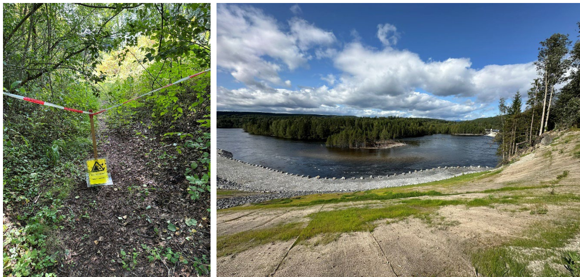
Figur 6-4 Bilder av resterende sti som er stengt og av sikringstiltak langs Begna. Kilde: Stack Infrastructure
