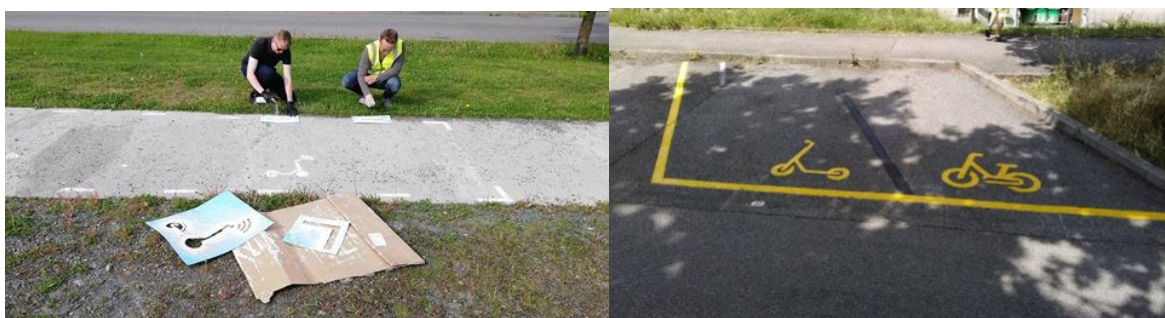
Figur 7. Testing av oppmerking av parkeringssoner med spray. Deretter permanent oppmerking. Underveis ble malingen endret fra gul til hvit, i tråd med nasjonale retningslinjer.
